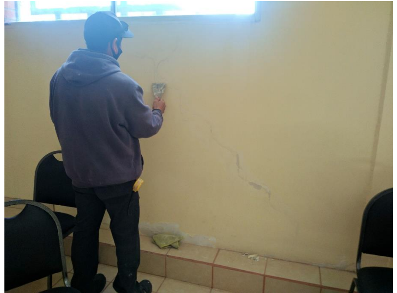
Reparación de cuarteaduras en la tercer aula enero 2023
