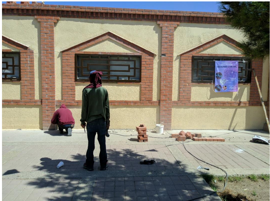
Instalación de rodapié julio 2023
