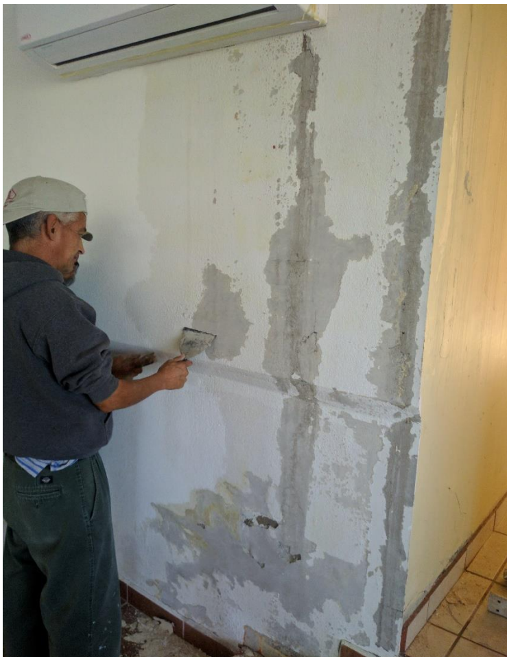
Mantenimiento correctivo en planta alta, resane de paredes. Noviembre 2023
