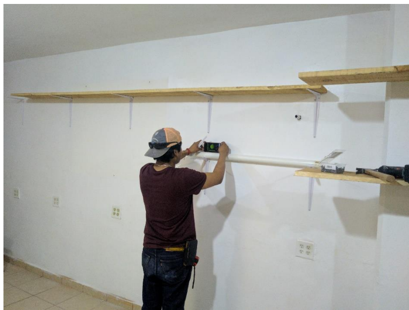
Rehabilitación área de biblioteca Junio 2023
