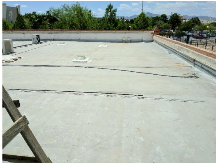
Limpieza de techo y terraza agosto 2023
